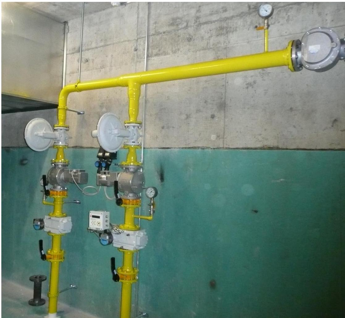
Bild: Gas-Strasse zu Heizung und BHKW
