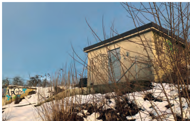
Altes Wasserreservoir Breitenloo, Foto: ibk
