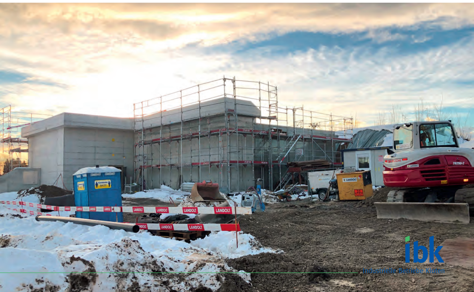
Neubau Wasserreservoir Breitenloo, Foto: ibk
